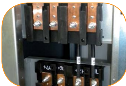
PARTICOLARE DEL VANO DI ATTESTAZIONE CAVI DC
