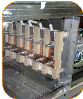
PARTICOLARE DEL VANO DI ATTESTAZIONE CAVI DC.
