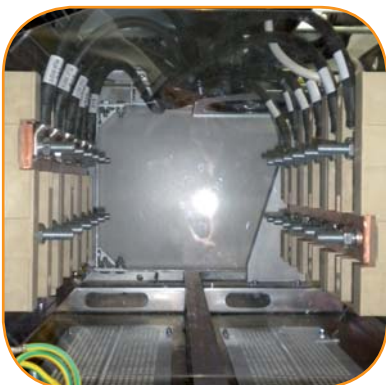
PARTICOLARE DEL VANO DI ATTESTAZIONE CAVI DC.
