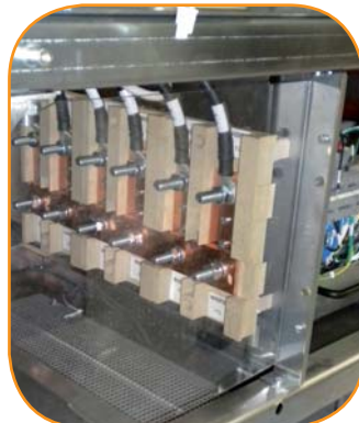
PARTICOLARE DEL VANO DI ATTESTAZIONE CAVI DC.
