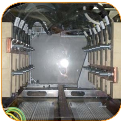
PARTICOLARE DEL VANO DI ATTESTAZIONE CAVI DC.
